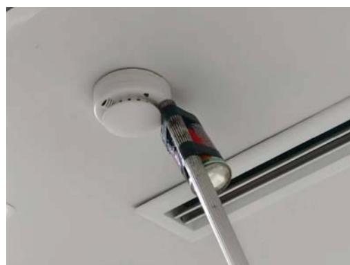
ตรวจสอบ Smoke Detector
