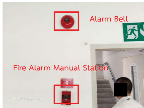
Alarm Bell และ(Fire Alarm Manual Station)
