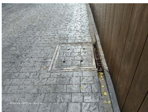
บ่อ Man Hole ที่ใช้เป็นระบบบ่อน้ำ
