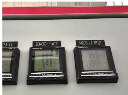
มิเตอร์ระบบบำบัดน้ำเสียแยกจากมิเตอร์อื่นๆ
